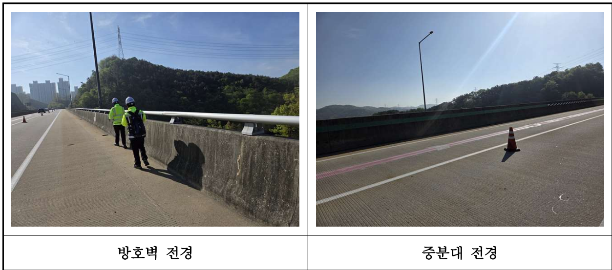
【사진 31.3.24】 방호벽 및 중분대 전경
