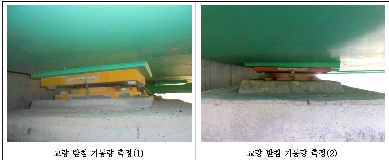
【사진 31.3.16】 교량받침 이동량 측정
