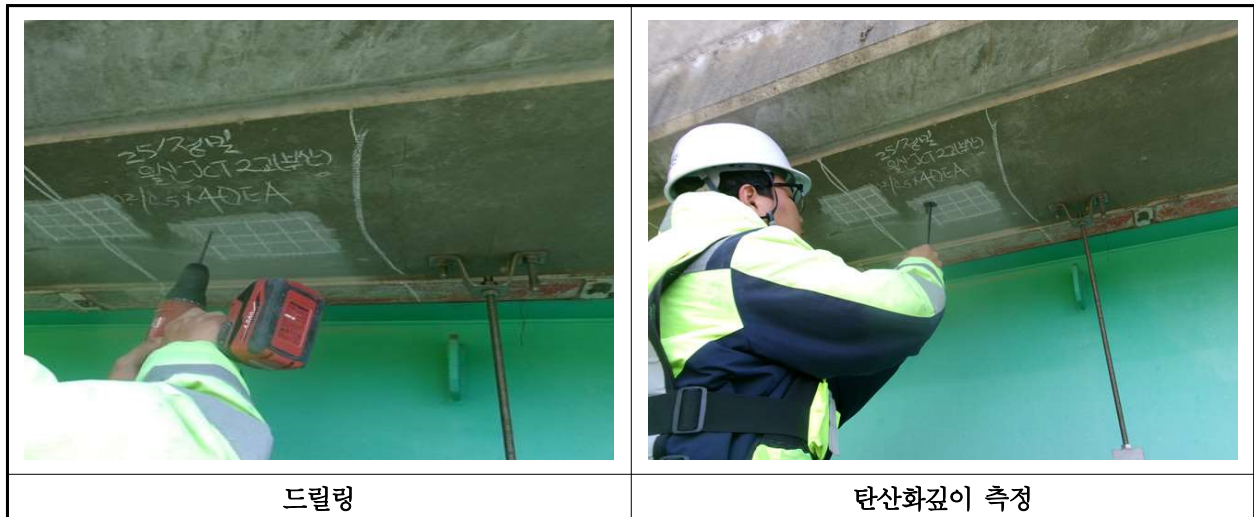
【사진 31.4.3】 탄산화 깊이 측정 현장사진
