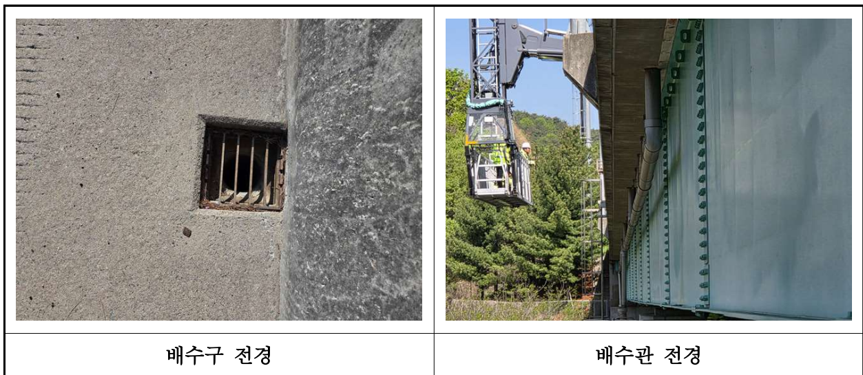
【사진 31.3.22】 배수시설 전경
