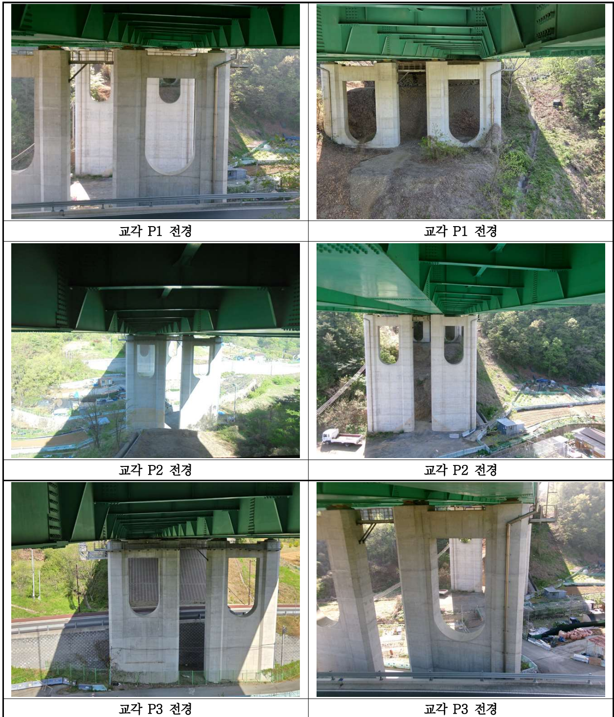
【사진 31.3.10】 교각 전경
