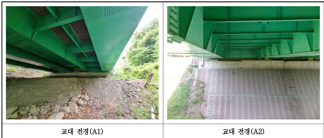
【사진 31.3.8】 교대 전경
