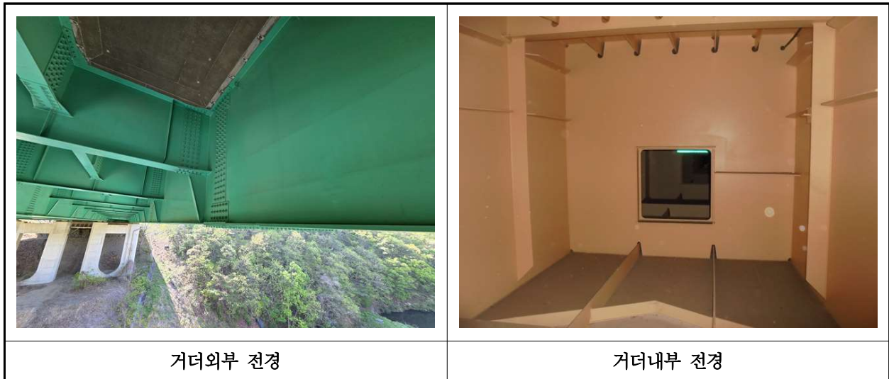
【사진 31.3.4】 거더 전경
